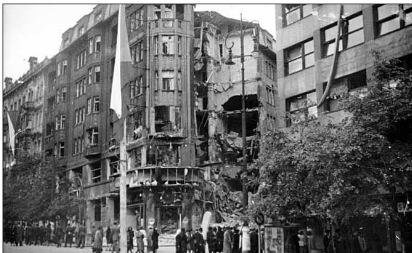
Rohový dům s kavárnou Parlament a obchodem Prokop a Čáp po zásahu bombou, 1945
